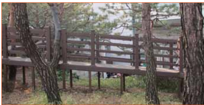
Фото 10. Ограждения, имитирующие натуральное дерево, из вторичного пластика
