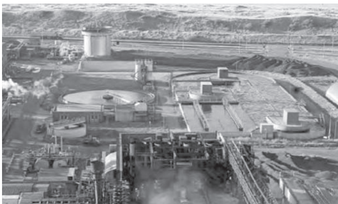
Рисунок 5.24: Вид сверху установки для биологической очистки сточных вод компании Corus, Эймейден, Нидерланды
