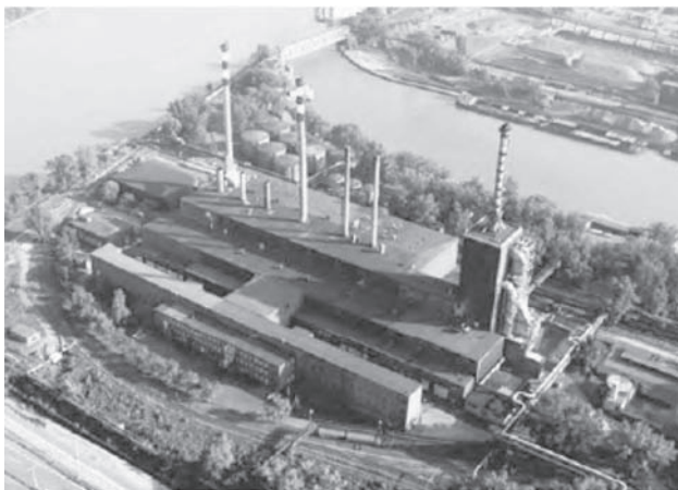
Рис. 2.6. Вид электростанции на заводе с полным циклом [281]
