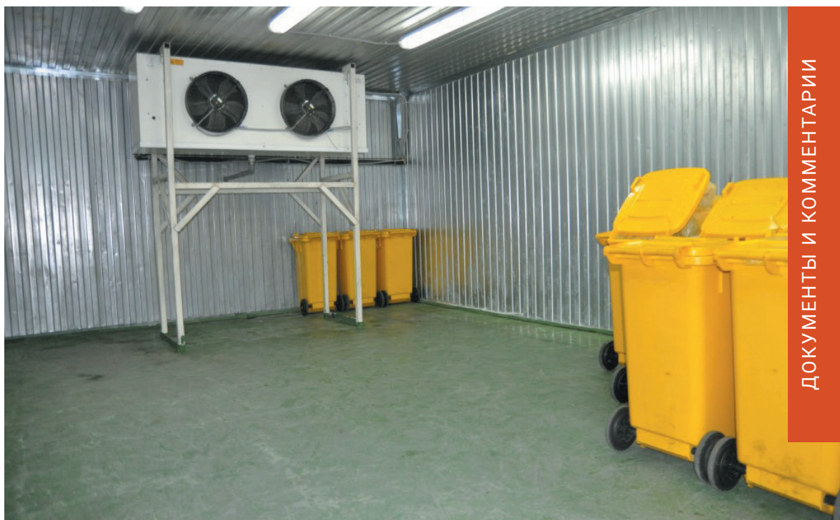
Рис. 2. Оборудованные места для накопления пищевых отходов
