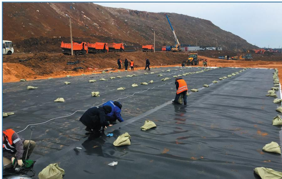
Фото 2. Монтаж противофильтрационного экрана из геомембраны
