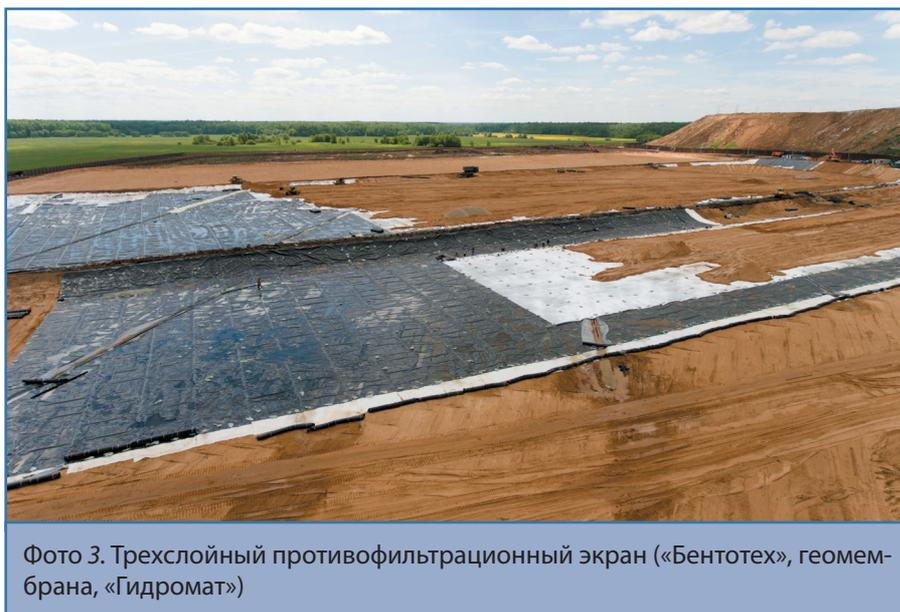
Фото 3. Трехслойный противофильтрационный экран («Бентотех», геомембрана, «Гидромат»)
