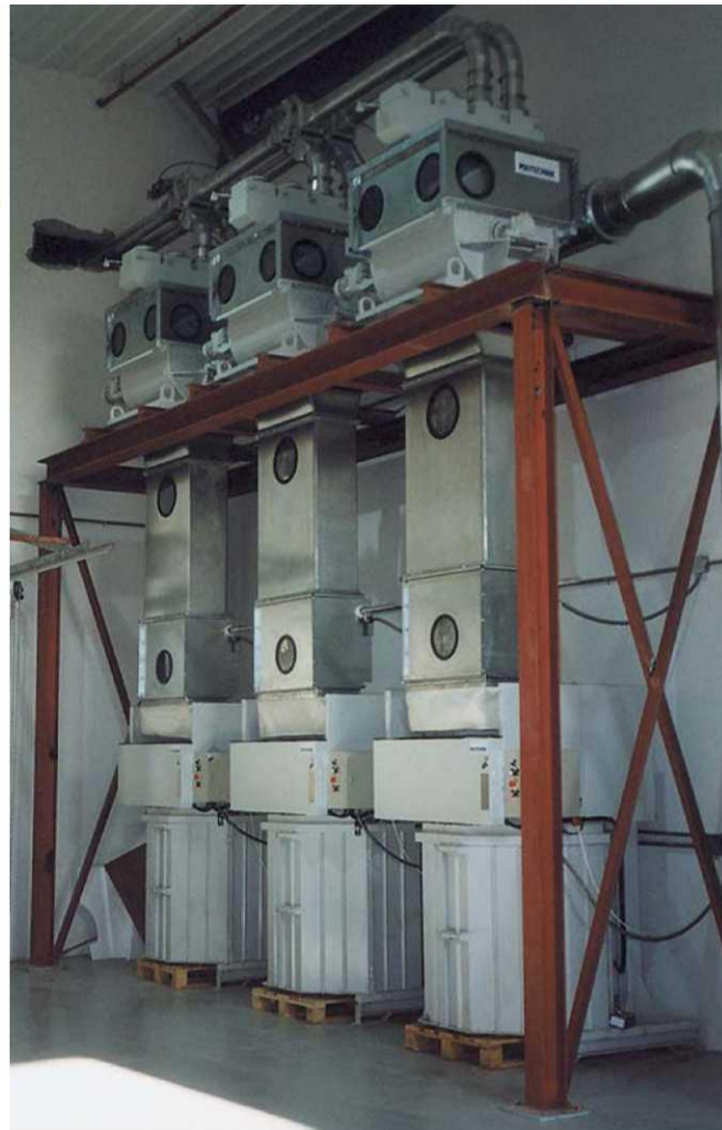
Сепаратор PMA с системой сортировки материала, расположенный над прессами
