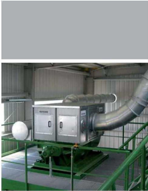
Сепаратор PMA в звукоизоляционном корпусе
