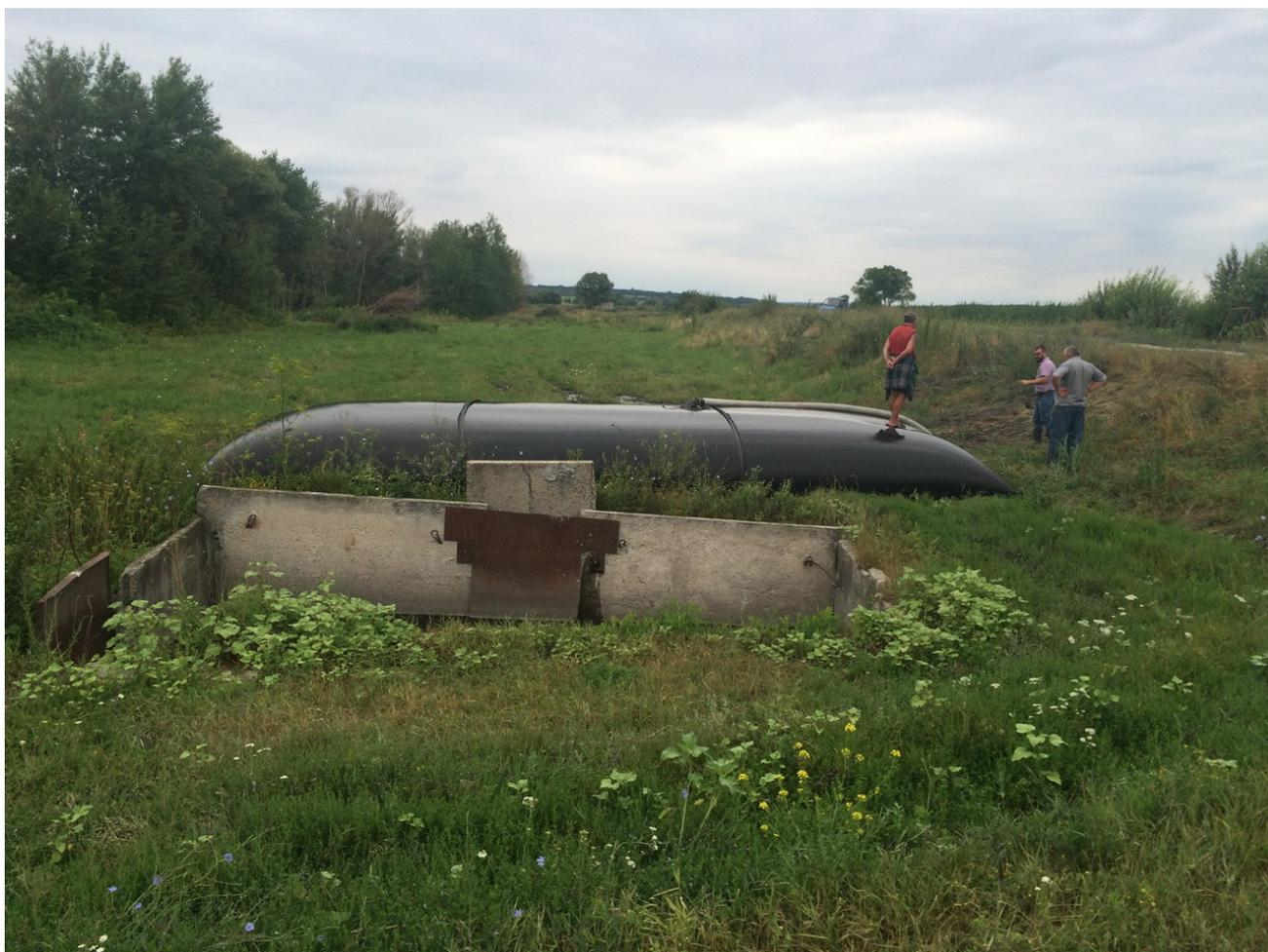
Технология обезвоживания осадка подразумевает укладку геотуб на площадке в непосредственной близости к очищаемому объекту. При необходимости дополнительной очистки фильтрата предусматривается система гидроизоляции площадки (например, с помощью геомембраны) со сбором воды и ее последующей подачей в очистные сооружения. При отсутствии химических и других опасных загрязнений допускается подача воды обратно в водоём.
