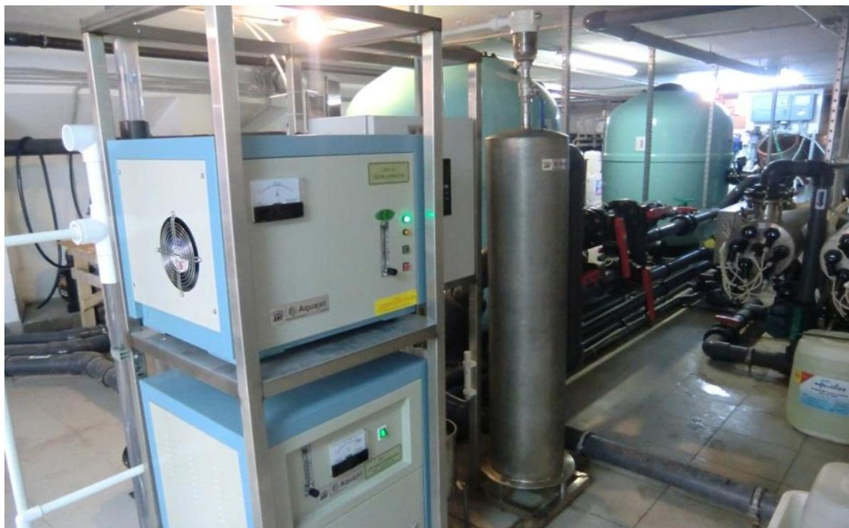
**10.** Для нужд СПА фитнес-центра «Альфа» выполнена разработка, изготовление и монтаж системы фотохимической очистки воды бассейна объемом чаши 280 м<sup>3</sup>.
