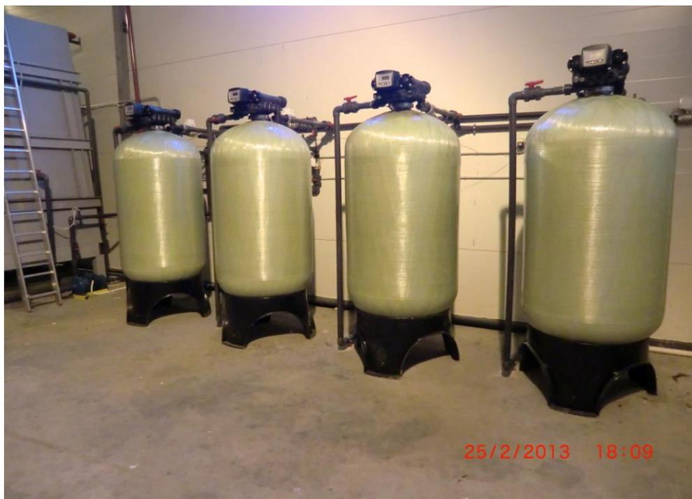
13. Для нужд ЗАО «Металлопторг» разработана технология очистки ливневых стоков до нормативов на прием канализационных стоков, согласованных с Водоканалом Санкт-Петербурга. Реализована эффективная очистка сточной воды от нефтепродуктов, СПАВ, ионов железа, марганца, алюминия, меди, цинка.
