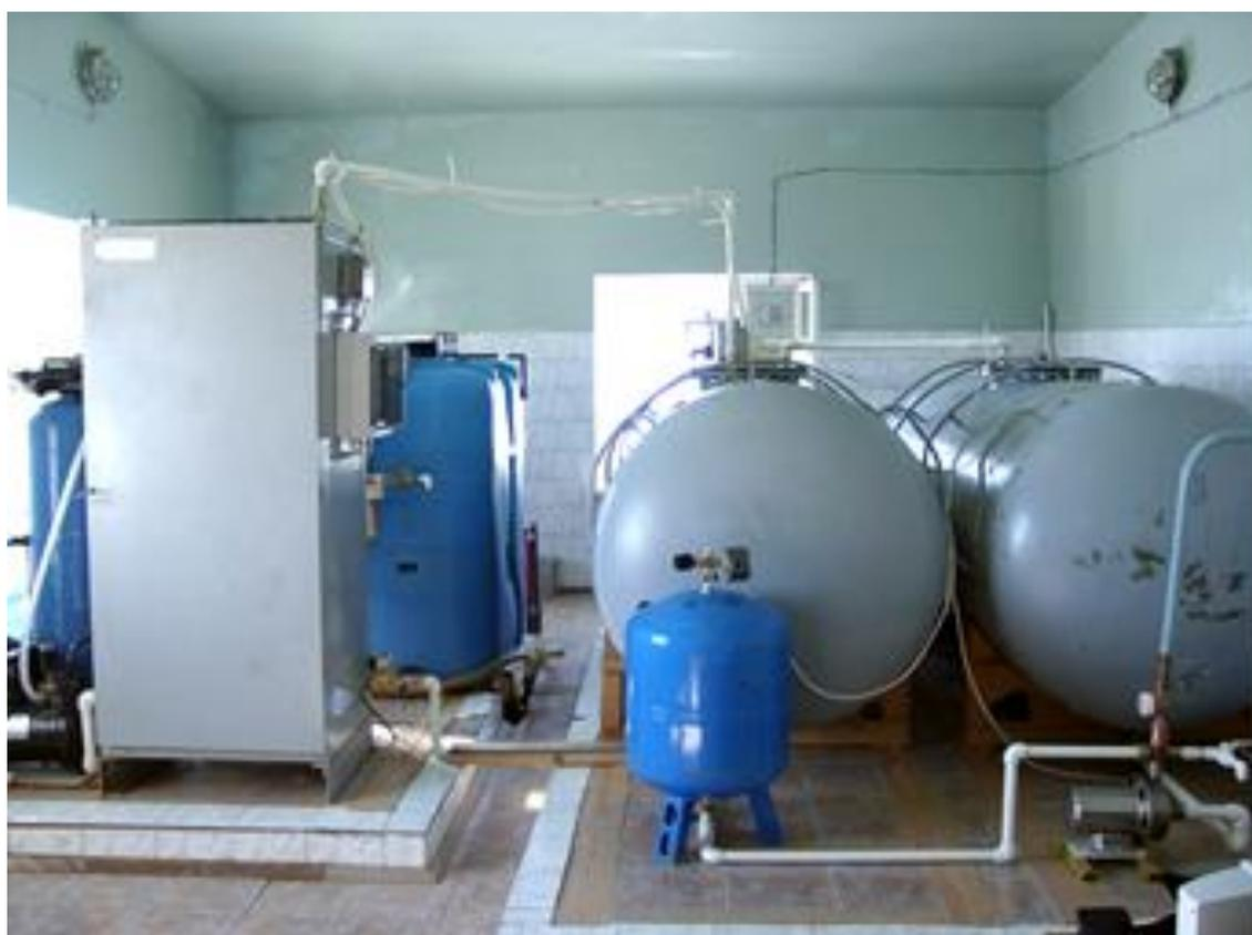
4. Для **Управления ФСБ России** (Резиденция К-20) были разработаны и поставлены системы обезжелезивания и ультрафильтрационной очистки водопроводной воды до норм СанПин с использованием уникальных керамических мембран оригинального наноселевого типа и производства партнерской компании.
