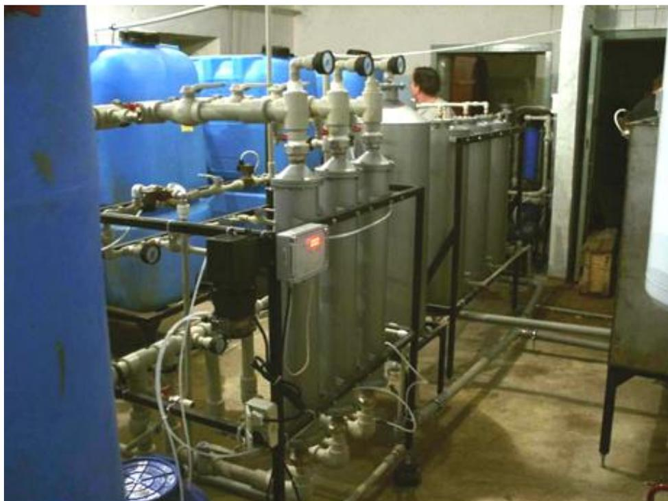
6. Наша компания участвовала в разработке технологии и поставке современного оборудования глубокого обессоливания воды для подпитки котла высокого давления парогазовой электростанции **ОАО «Мордовцемент»**.
