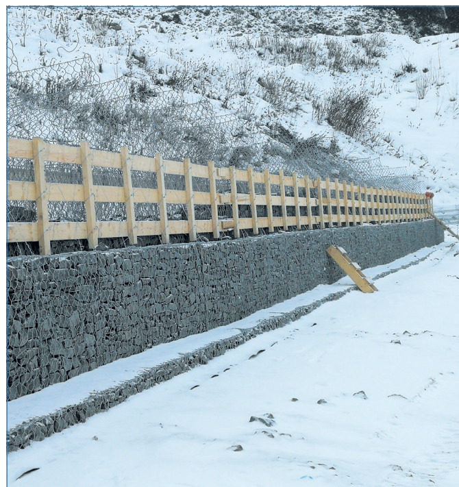
Фото 2. Габрионная стена по контуру в основании полигона
