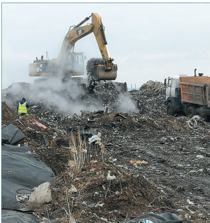
Фото 1. Работы по формированию откосов
